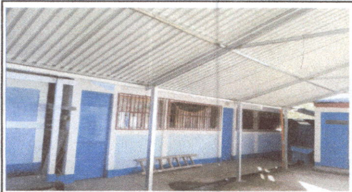
Foto 3: Sustitución de estructura de soporte de madera por metal modulo I.
