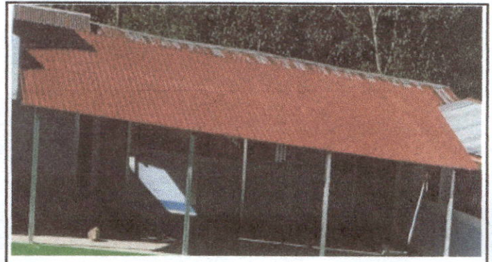
Foto 4: Sustitución de lámina por lamina troquelada aluzinic calibre 26 Modulo I.
